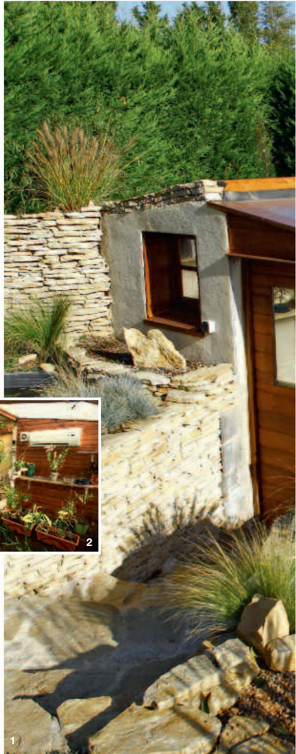
Fig. 2. – Un exemple des revêtements possibles utilisés en bardage ou parement (bois lasuré, pierres sèches) (Photo J.-F. ROUSSELOT).
